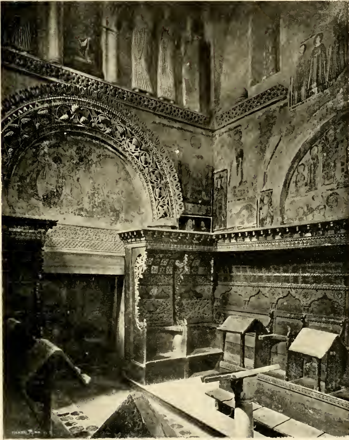
Fig. 165 — Interno della chiesa di Santa Maria in Valle a Clivdale (a. 762-776)
